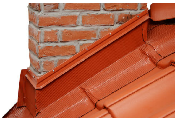
Montering av skorstenstätning
