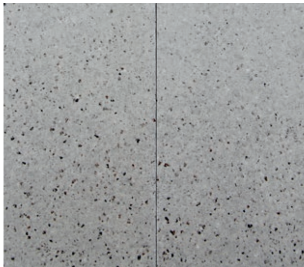
Fog med raka kanter ställ högre toleranskrav
